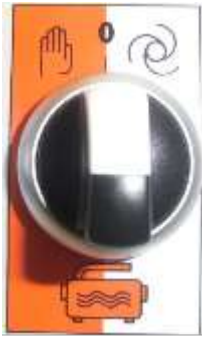
Abb. 21: Wahlschalter Druckerhöhungspumpe
